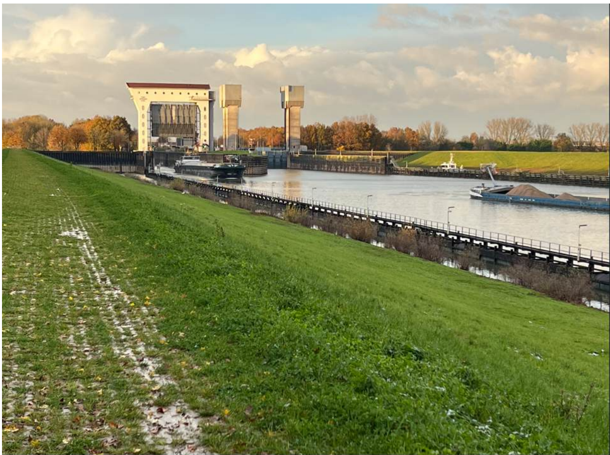
Sluis bij Tiel Amsterdam-Rijnkanaal
